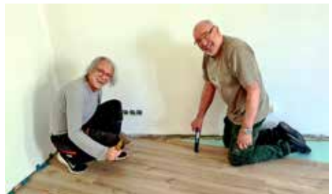
Wolfgang Kleßen und Sohn verlegen den neuen Boden
