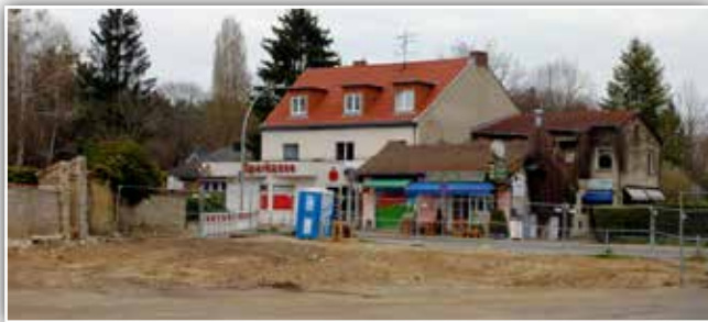
Das Gebäude der ehem. Freiwilligen Feuerwehr ist abgerissen, 2021
