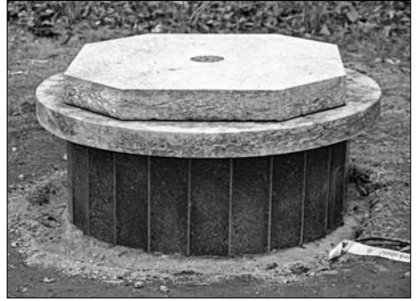
Der Sockel ist verkleidet, die Deckplatten sind aufgelegt Foto: Rainer Nitsch
