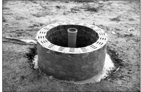
Das Fundament ist gelegt, der Sockel aufgemauert
