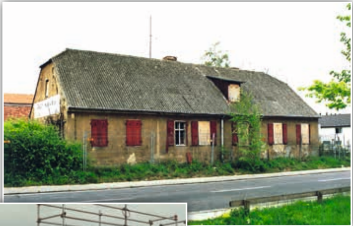
Das alte Mühlenhaus am Ritterfelddamm 1988
