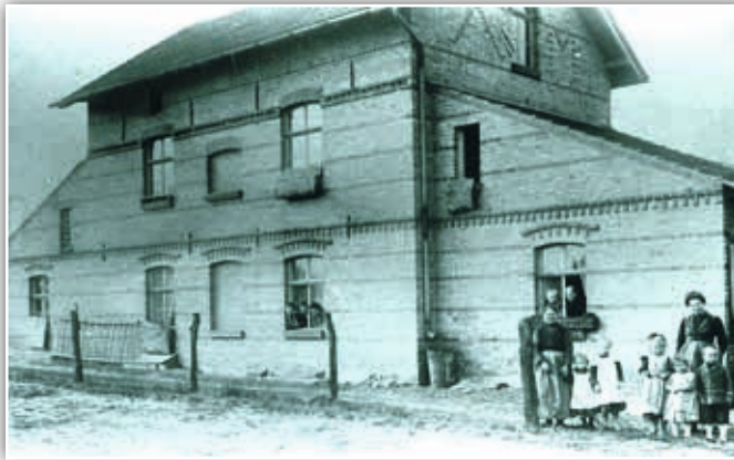
Gebäude mit Motormühle am Ritterfelddamm
