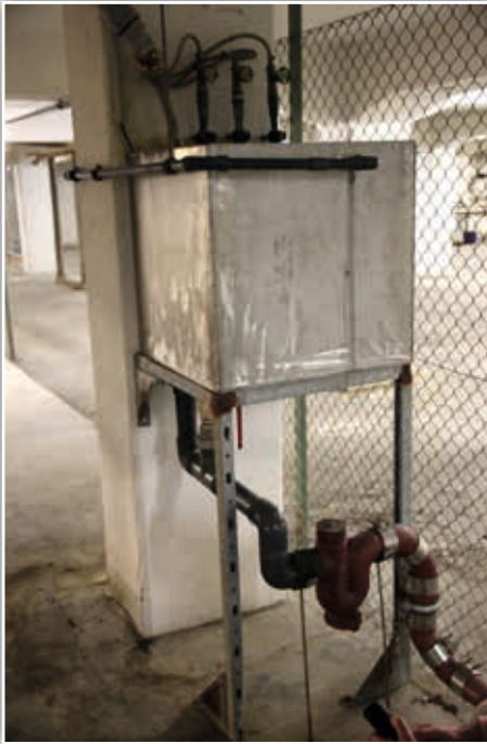
Der Wasserbehälter mit Umwälzpumpe
