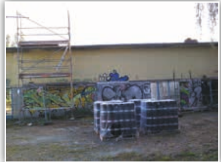
Vorbereitung der Sanierung des Casinos August 2016
