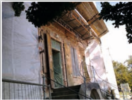
Putzabschlag am Giebel des Herrenhauses August 2016
