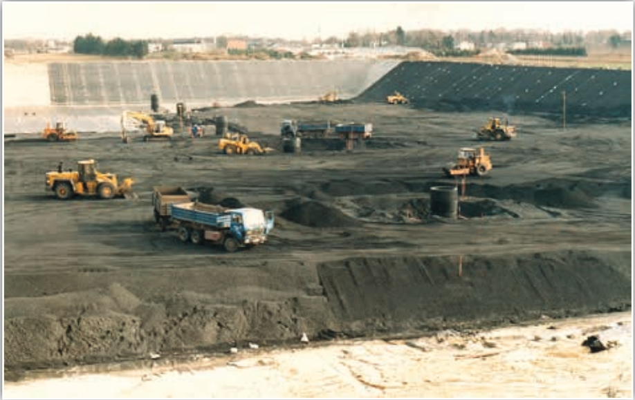
Arbeit in der Kohlengrube März 1989
