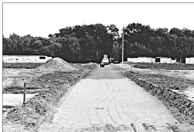
Ehem. Grenzstreifen. Der Krampnitzer Weg wird planiert
