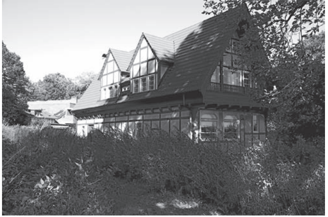
Haus Maubach Imchenallee 72A nach der Restaurierung Foto: Rainer Nitsch
