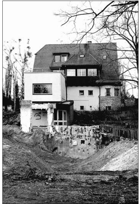
ehem. Haus Cartun, im Vordergrund Reste der Kapelle des Klosters, Lüdickeweg Foto: Rainer Nitsch
