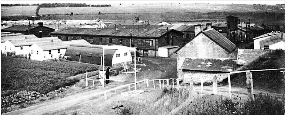
Kriegsgefangenenlager Barlin, Département Pas-de-Calais, 1945
