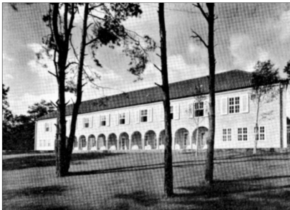
Blick auf das sog. Auslandshaus 1940
