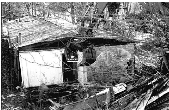
Abriss der Baracken am Dechtower Steig
