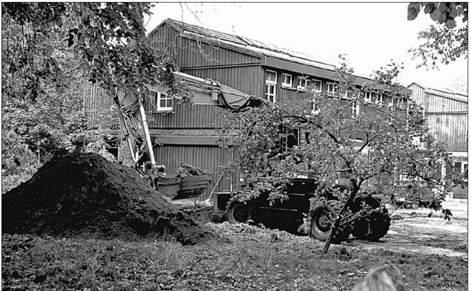
Planierarbeiten im Garten des ehem. Ella-Kay-Hauses
