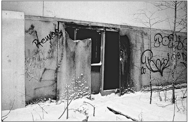
Front der Kantine zerstört 2005
